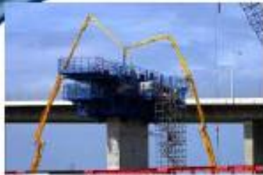
Pier 10a - Pier 15
